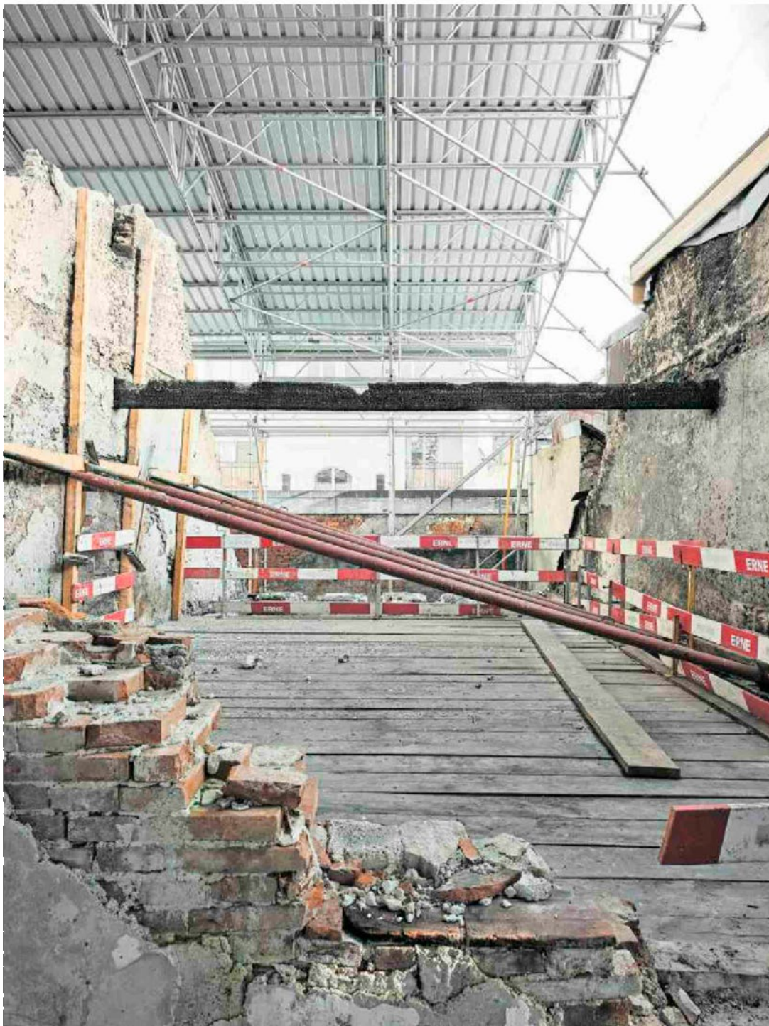
Die oberste Etage des Rheinhofes wird mit einem provisorischen Dach geschützt.
